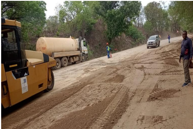
Foto: Construção/ Reabilitação da estrada Nacional nº1 no troço Inchope – Caia
