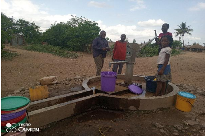
Foto: Construção de furos de água potável na comunidade de Chirimba2 - Caia
